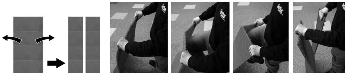
Pour déclipser facilement des dalles posées au sol, insérer une spatule rigide entre les œillets puis incliner la spatule pour permettre à l'œillet de se déclipser.
